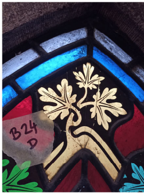
verres brisés ou altérés (lancette D6 et rose)
