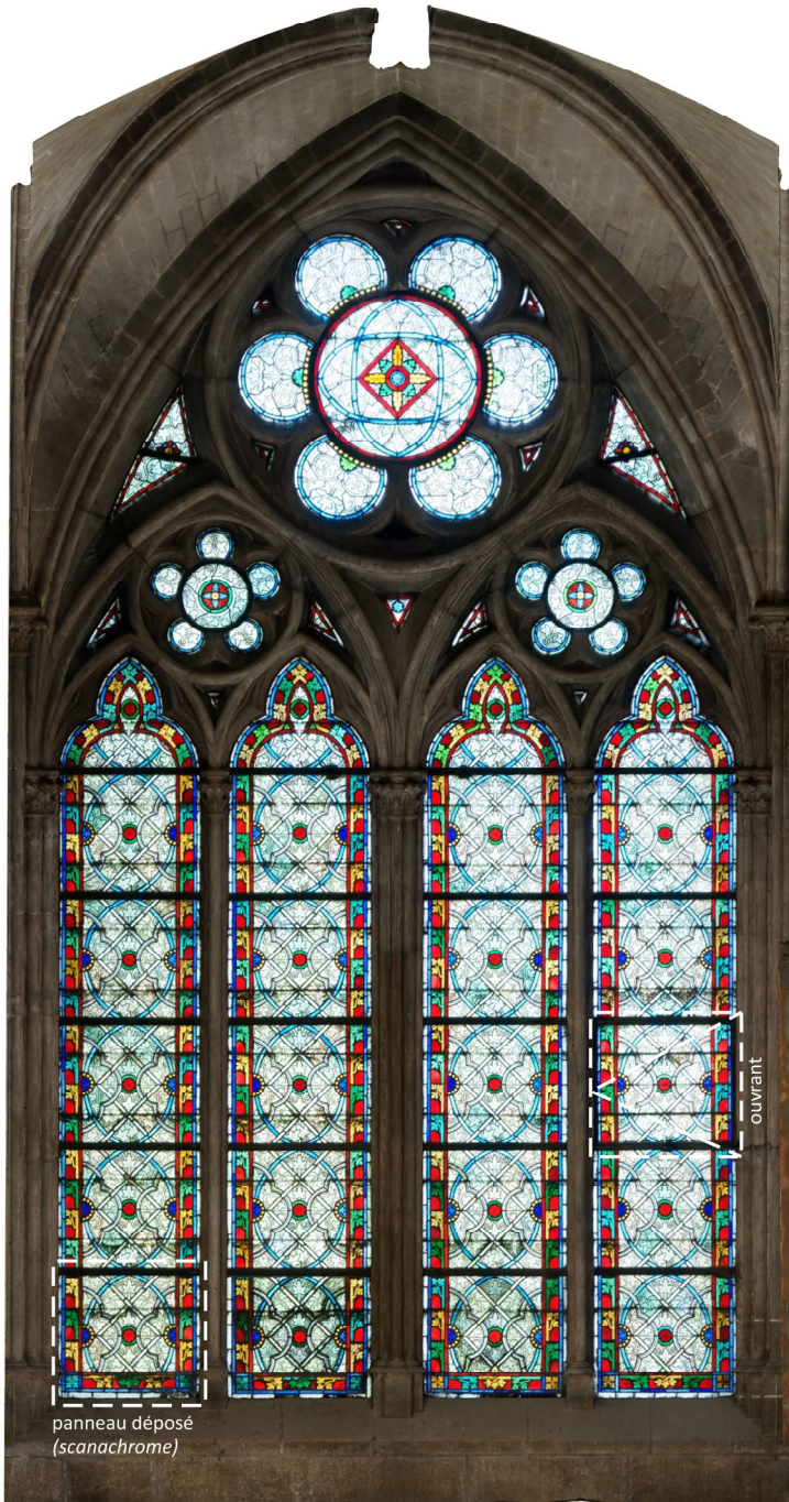
verres brisés ou altérés (lancette D6 et rose)
