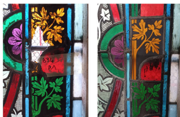
remplacement pièce brisée A1 (ci-dessus)
