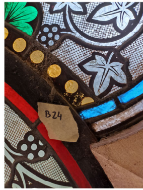
verres brisés ou altérés (lancette D6 et rose)
