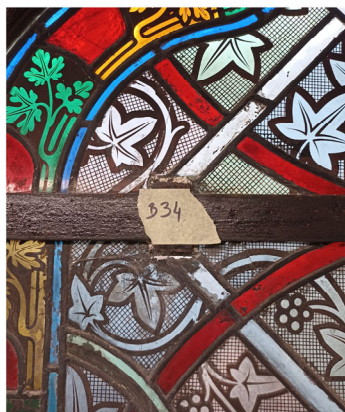
remplacement pièce brisée A1 (ci-dessus)
